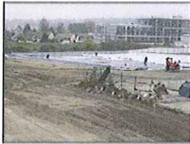
◀ Mise en place des géomembranes et géotextiles ▶
